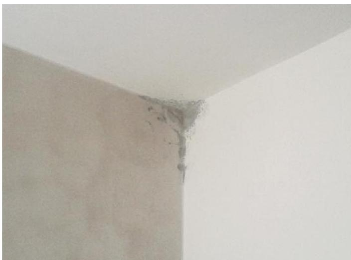
Preesistenti problemi di muffa in corrispondenza di ponte termico strutturale e geometrico. Temperatura della parete inferiore a **15 °C con temperatura esterna 5°C.**
